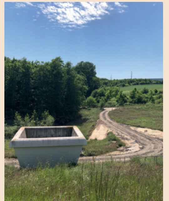
Das Regenrückhaltebecken jenseits der B1 schützt die Ostdörfer. Für Massen wird so ein Bauwerk für die vorübergehende Speicherung von Wassermassen dringend gebraucht. Doch die Planungen ziehen sich hin.
