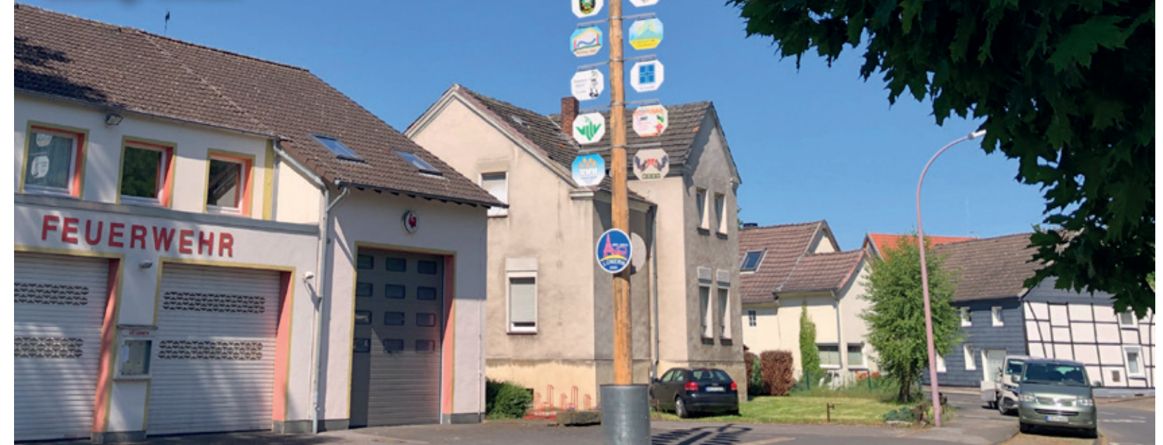
Das Gerätehaus in Lünern ist nicht nur Standort der Freiwilligen Feuerwehr, sondern auch ein Treffpunkt im Dorf. Hier finden Feste statt, zuletzt wurde der traditionelle Maibaum aufgestellt. Der neue Brandschutzbedarfsplan sieht eine Zusammenlegung von Feuerwehr-Standorten vor.
